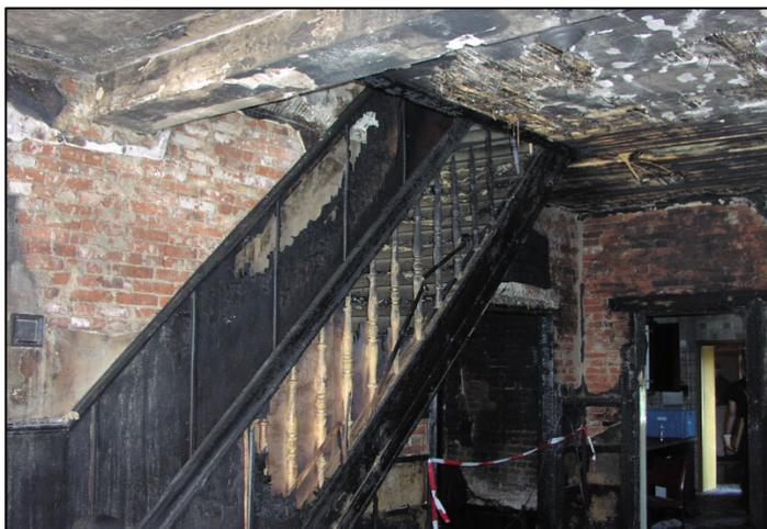
Ein Blick auf den Entstehungsherd (unten rechts). , Durch die starke Hitzeentwicklung ist der Putz von Wänden und Decke geplatzt, die Holzterasse ins Obergeschoss und tragende Balken sind schwer in Mitleidenschaft gezogen.
